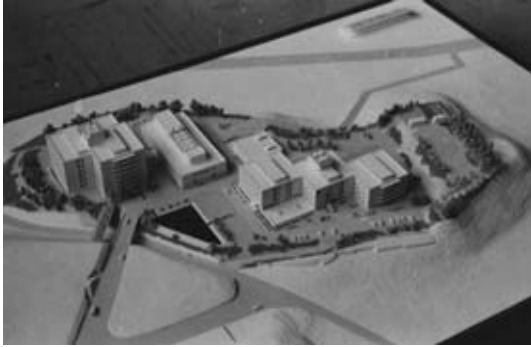
写真2. 生理研と基生研の基本設計モデル 生理研棟(左7階建) 共通施設棟(中央2階建) 基生研棟(右4階建)(1976.12)
