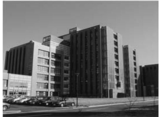
写真8. 山手地区岡崎共通研究施設
